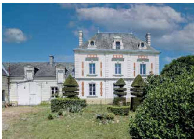
Dans la campagne du Véron entre Saumur et Chinon, un ensemble immobilier d'environ 700 m 2 à réhabiliter et son vaste jardin Ref 969322 Vente en exclusivité - 400 000 €
