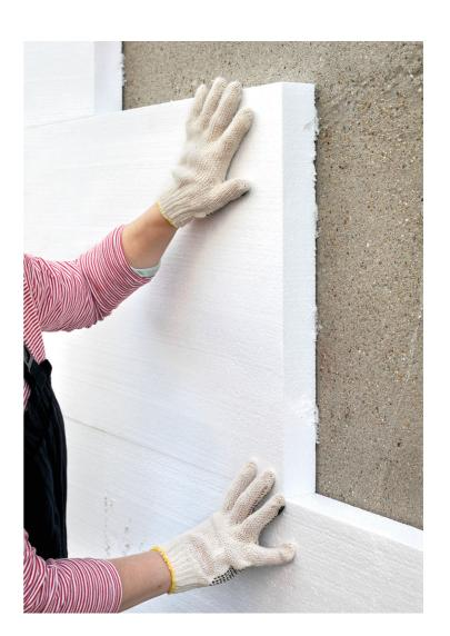
ITE, peu importe la nature de l'isolant et du support. Ici, le matériau choisi tient grâce à un système de fixations traversantes utilisant des chevilles à expansion. Dans le dernier cas, on utilise des rails PVC prépercés et fixés mécaniquement avec des chevilles à frapper sur le support. Mais cette dernière technique est réservée aux panneaux en polystyrène expansé blanc.
